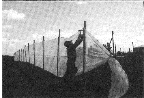
上. 植付け、中、覆土 下. 防風ネット設置
