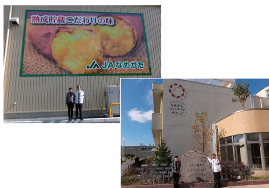
図6 新設したキュアリング定温貯蔵庫・なめがたファーマーズヴィレッジ
