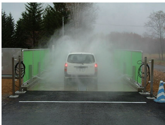
写真2 自動車両の洗浄装置
