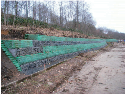
写真3 法面崩落防止工事
