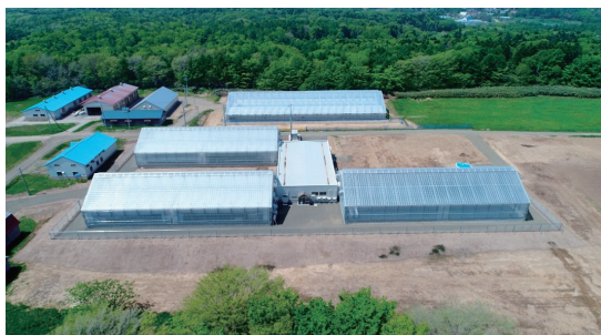
写真8 緊急増殖施設
