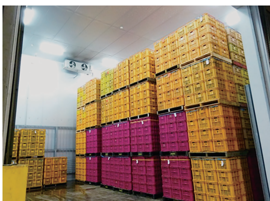
図1 試験に用いたキュアリング庫(加湿機能付き)
