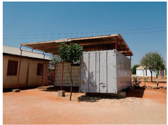
写真5 現地に導入した20FT コンテナ型の貯蔵庫（右）と1.5坪型の貯蔵庫（左）
